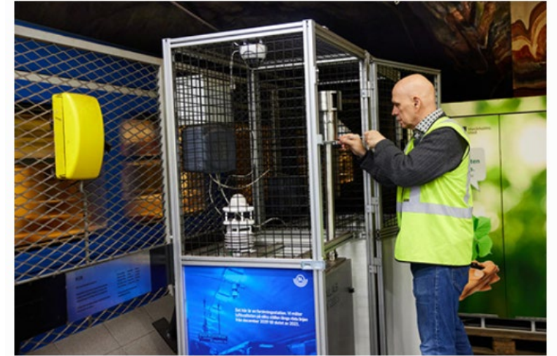
Mätning av luftkvalitet i spårtunnlar.
